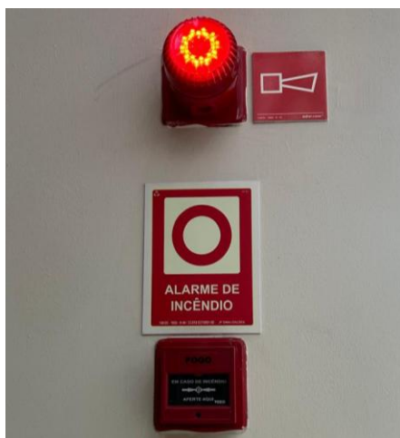
Figura 2: Sirene de alarme em funcionamento após acionamento manual da botoeira
